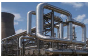
발전소 터빈, 스팀관로 단열
