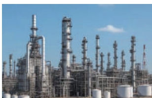
정유 및 석유화학 기기 및 배관 단열
